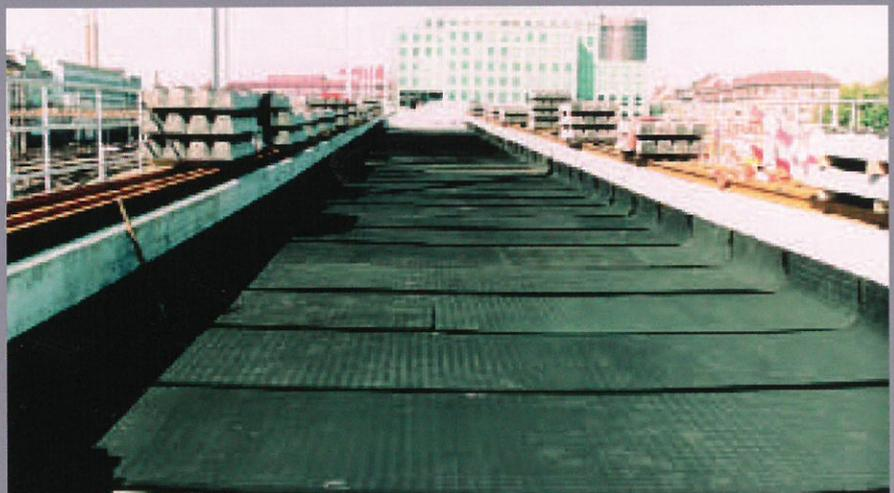
図7：コンクリート橋に敷設されたUSM®路盤マット（バラストを敷く前）
