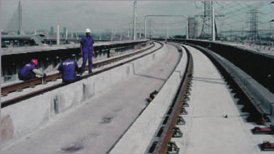
図8：コンクリートの下に敷設されたUSM<sup>®</sup> 路盤マット
