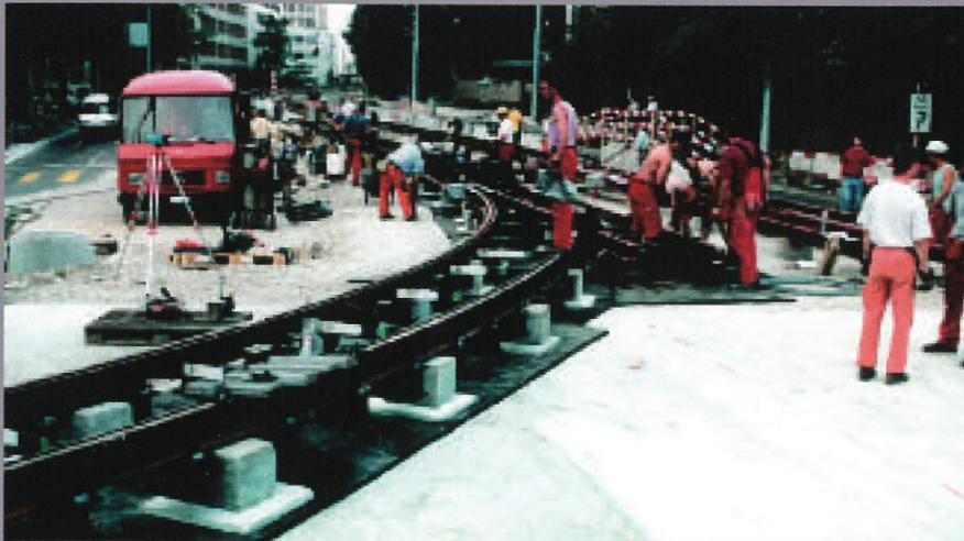
図12：路面軌道の軽量マス・スプリング・システムとUSM®路盤マット
