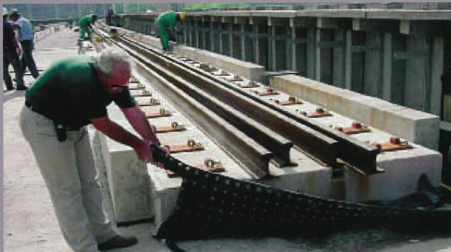
図11：軽量マス・スプリング・システムとUSM<sup>®</sup> 路盤マット
