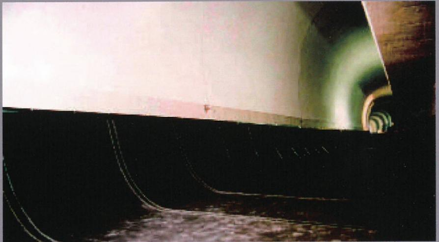
図6：バラストを敷く前のトンネル内のUSM®路盤マット
